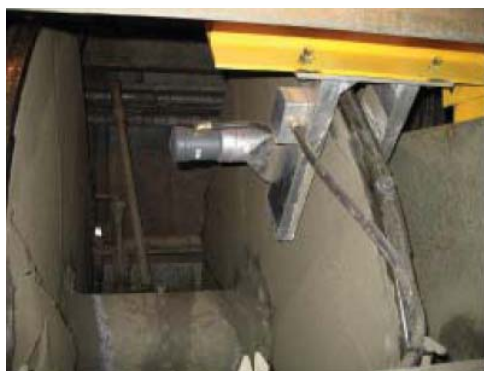
举例, MA-600, 转盘过滤器安装
